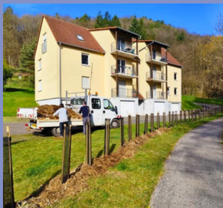
Chantier participatif de plantation de haies
