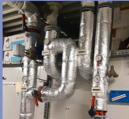
Travaux de calorifugeage des conduites à la piscine
