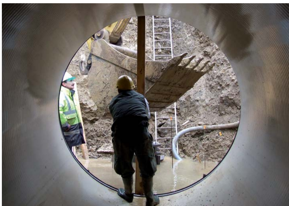
À raison d'un tuyau de 2,20 mètres de diamètre tous les 2 jours, la pose de cette énorme canalisation est un chantier spectaculaire !
