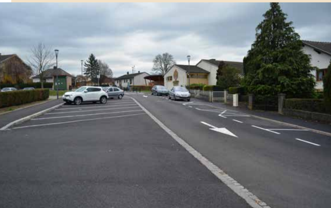
Le programme de sécurisation s'étend également aux abords des écoles et à leur accès. Ici, mise en circulation à sens unique de la rue du Stade reliant l'école maternelle du Montrouge à la nouvelle salle de sport.
