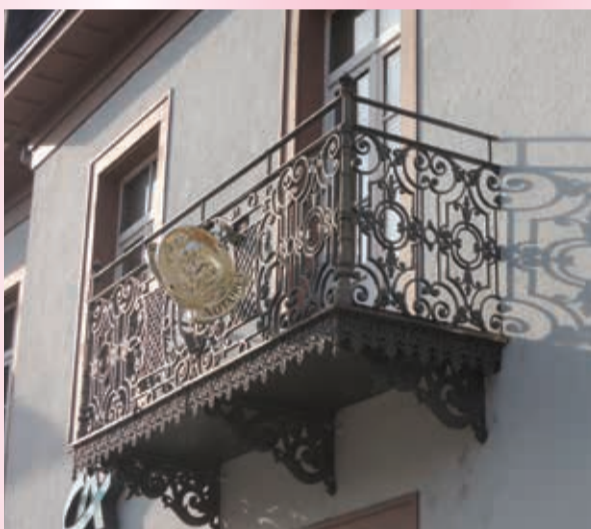
Le bureau de Dominique de Dietrich s'ouvrait sur ce balcon dont la balustrade existait déjà en 1892
