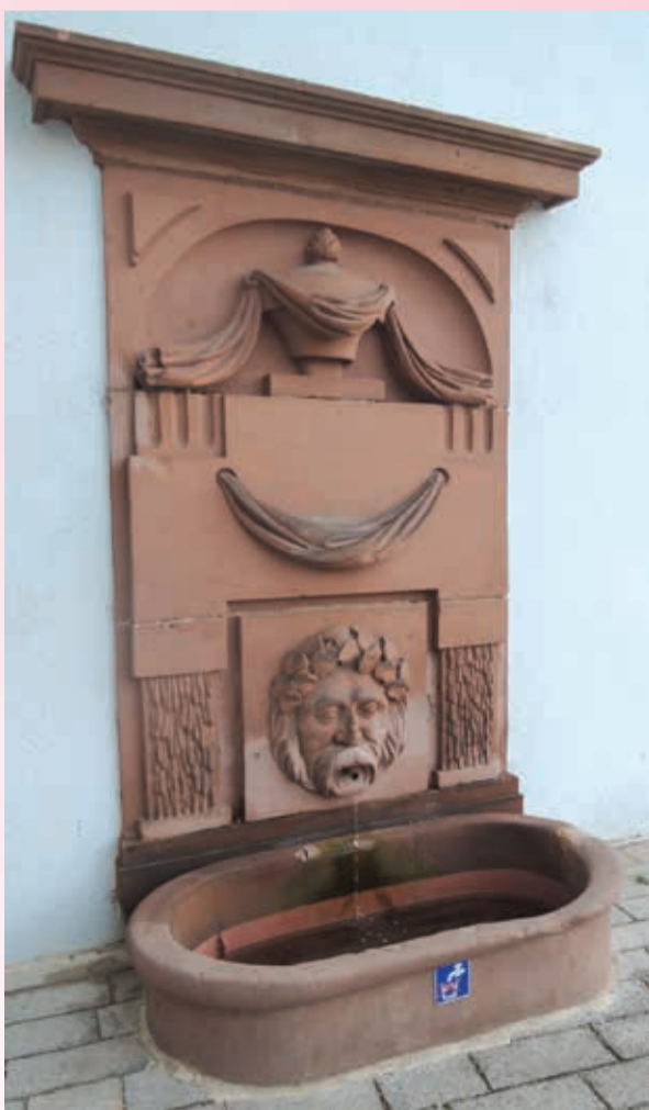
La fontaine à l'angle de l'immeuble coule à nouveau !
