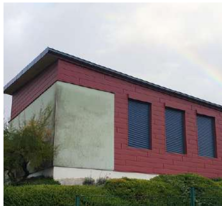
Remplacement du bardage et des fenêtres façade Sud de la maternelle du Montrouge (avant/après)
