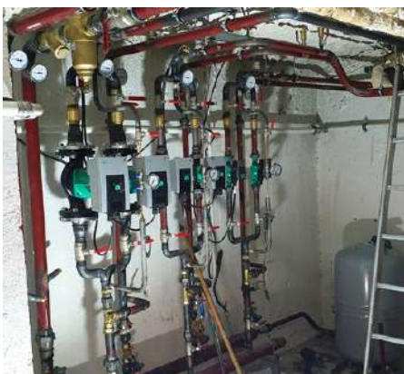
Nouveau collecteur de chauffage et installation d'une régulation à la maternelle
