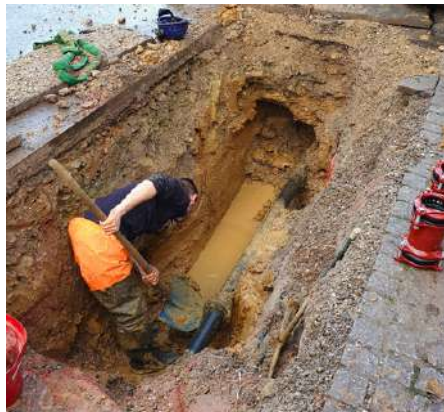
Réparation d'une rupture de conduite d'eau rue de l'industrie
