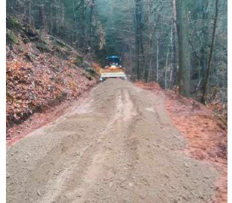
Remise en état du chemin forestier du Sandweg
