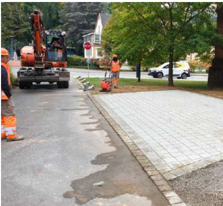
Création de places de parking près de l'église catholique
