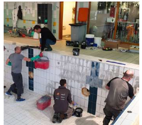
Réfection des joints du grand bassin des Aqualies
