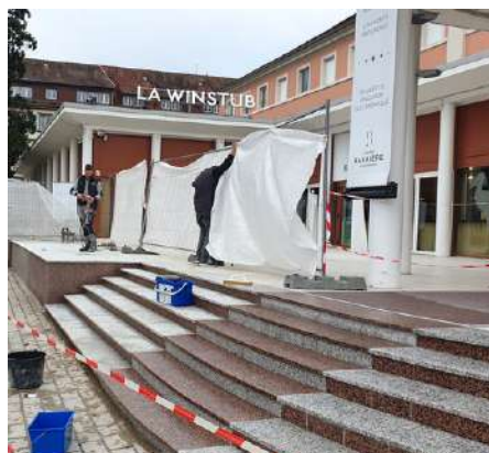
Réfection des escaliers du parvis du casino
