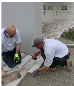
Remise en état du sol sous l'arche des vestiges romains
