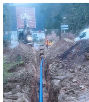
Nouvelle canalisation d'eau potable devant Celtic pour l'aménagement de l'entrée nord
