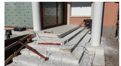
Réfection des marches du casino
