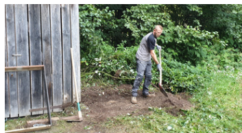
Installation des bornes de collecte des biodéchets
