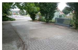
Reprise des pavés sur le chemin piéton de la piscine
